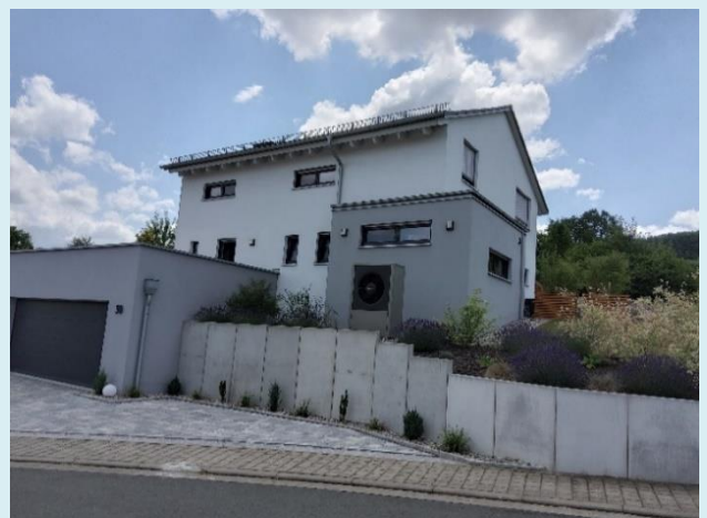
Abbildung f: Bsp. für Baualtersklasse J
