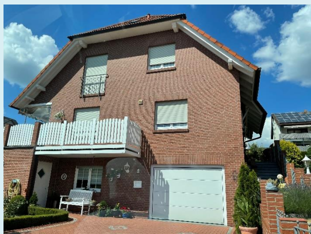
Abbildung e: Bsp. für Baualtersklasse I
