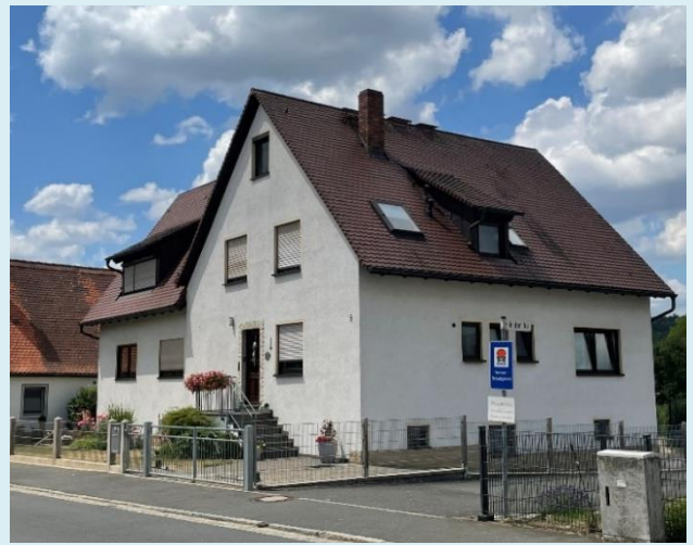
Abbildung b: Bsp. für Baualtersklasse C, D und E
