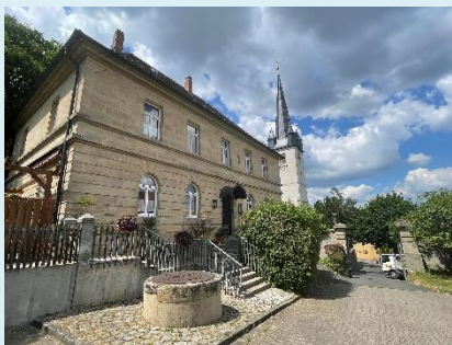
Abbildung d: Baudenkmal Pfarrstraße 2
